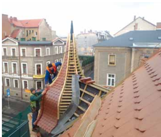
▲ Prace na narożnej wieży
