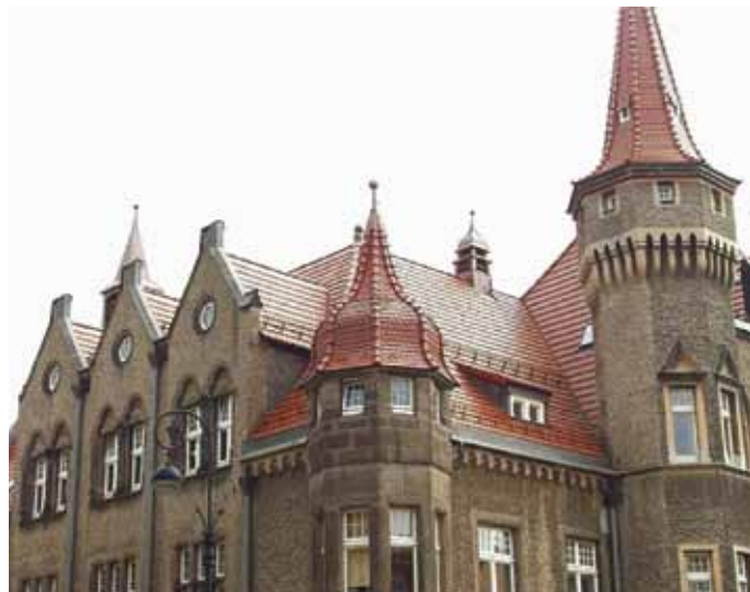
▲ Wykonawca remontu dachu, toruńska firma Agad uznaje go za jeden ze swoich obiektów referencyjnych
