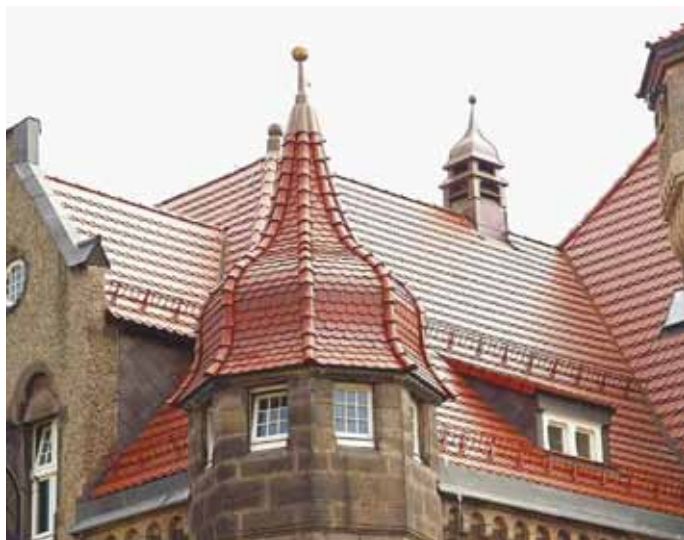
▲ Do krycia cebulastych wież użyto dachówek wieżowych, wyprodukowanych na specjalne zamówienie
