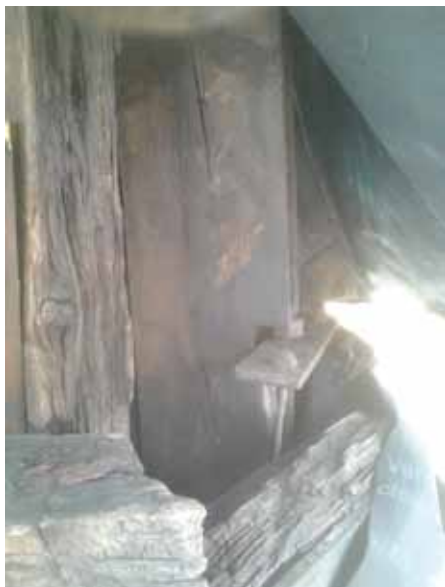
▲ Fragment konstrukcji nośnej jednej z wież
