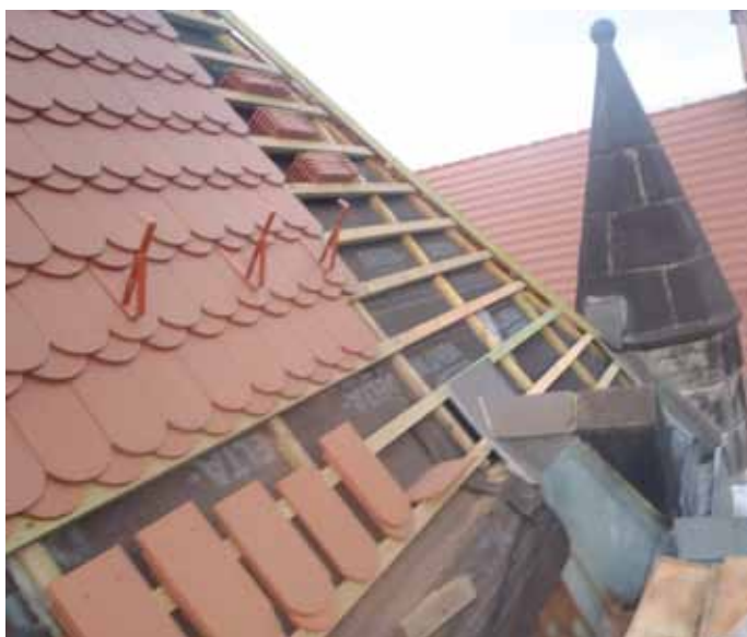
▲ Układanie nowego pokrycia na potaci
